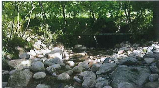
En fiskväg konstruerades förbi en högt liggande kulvert i Lydestadsbäcken.
